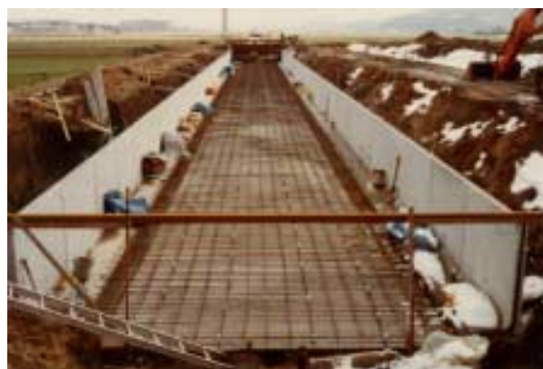
底版鉄筋の組立て
