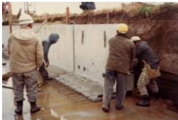
ブロック据付
