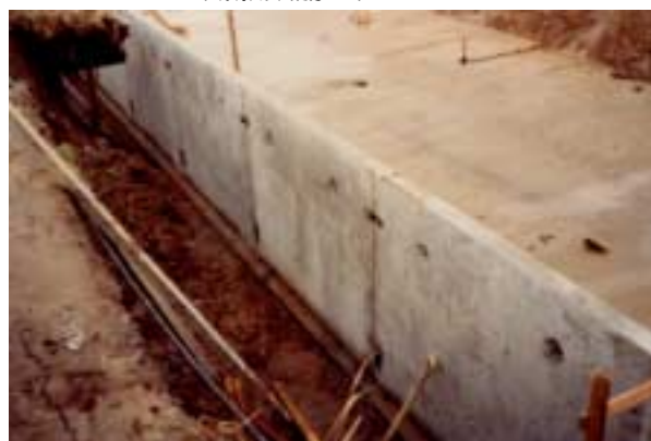
底版部のコンクリート打設
