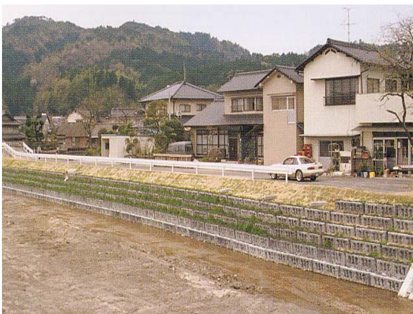
カゴボックス道路使用例 岡山県津山地方振興局一級河川宮川
