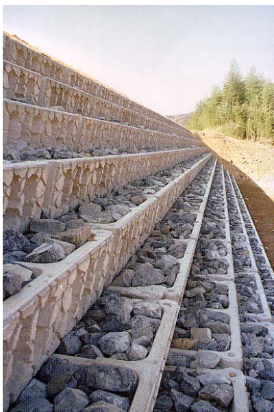
河川改修工事(吉野川)
