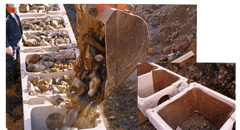
4. 吸出防止材の敷設
