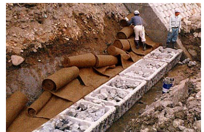
3. 中詰材の投入
