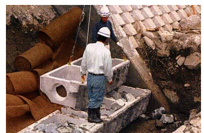
5. 裏込碎石投入後、2段目以降据付
