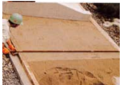
2. 敷きモルタルの施工
