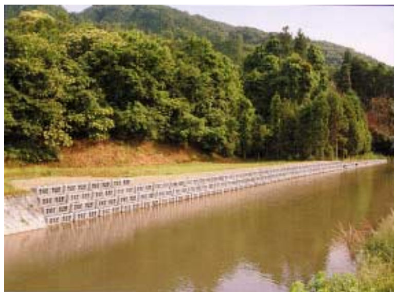
公共 H10 年発生河川災害復旧工事 688 (河内川)
