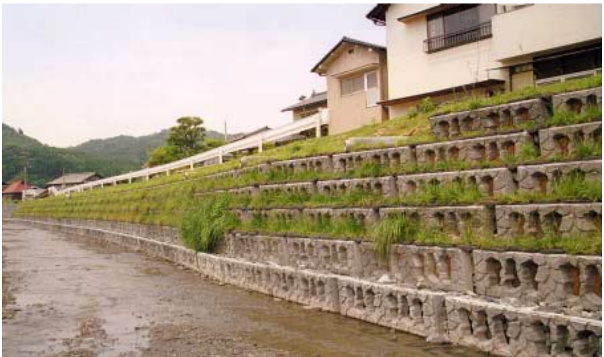
一級河川宮川地域総合整備対策河川改修工事(宮川)
