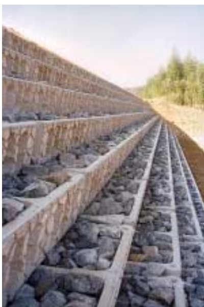
河川改修工事(吉野川)
