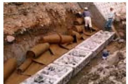
3. 中詰材の投入
