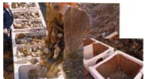
4. 吸出防止材の敷設
