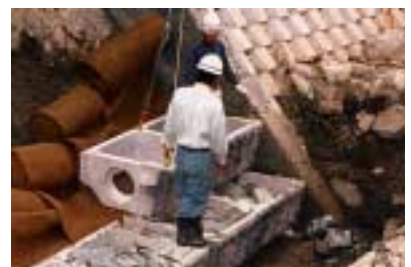
5. 裏込砕石投入後、2段目以降据付
