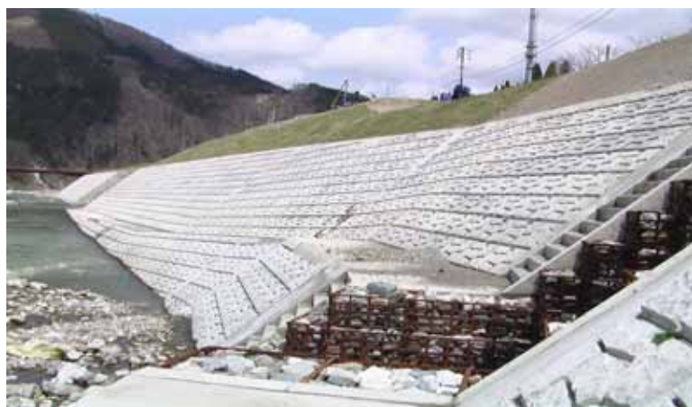
公共道路災害復旧工事 1割勾配 竜陣50型
