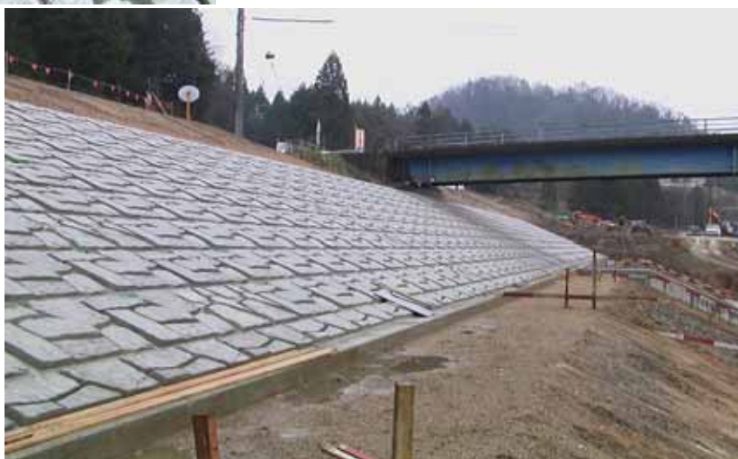
公共河川災害復旧工事 1割5分勾配 竜陣35型
