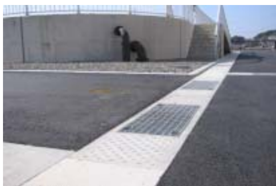
【上富田浄化センター】
