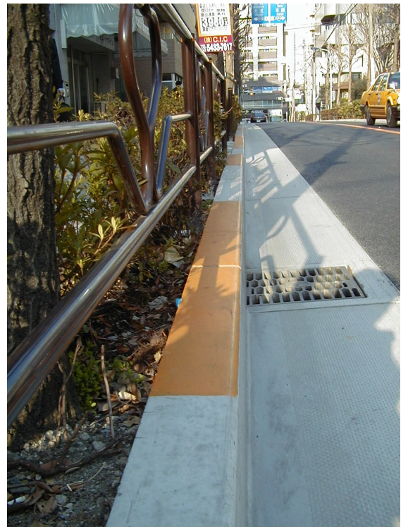
ノスキッド付きエプロンの施工例
